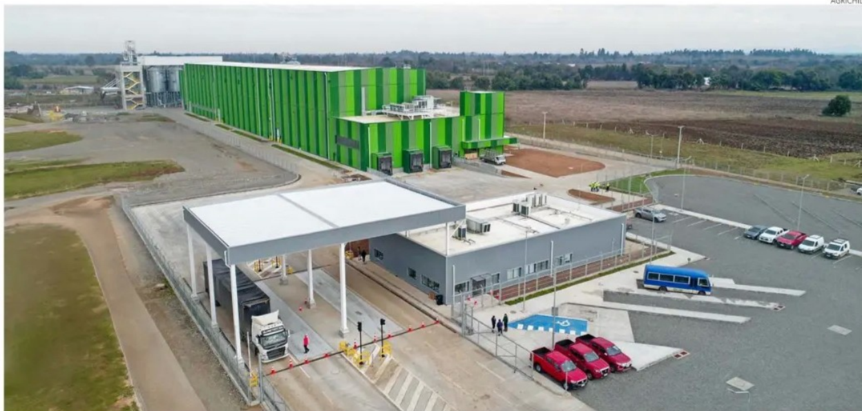
En 2024 se inauguró una planta de procesos en San Gregorio, Región del Ñuble, la que se espera ampliar próximamente.
